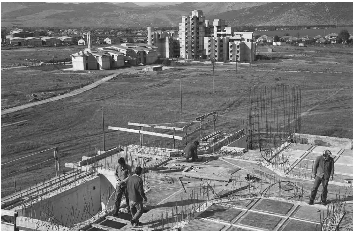
Izgradnja zgrade tehničkih fakulteta (u pozadini dio stambenog bloka Studentskog doma Rifat Burdžević – Tršo u Titogradu), 1975.
