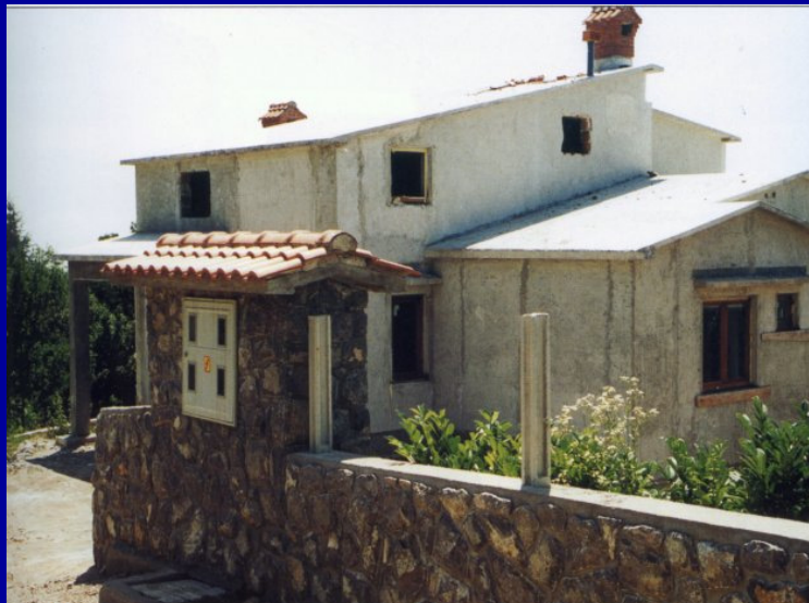
primjer položaja KPO kod priključka individualnog stambenog objekta
