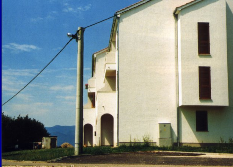
kablovski priključak sa stuba
