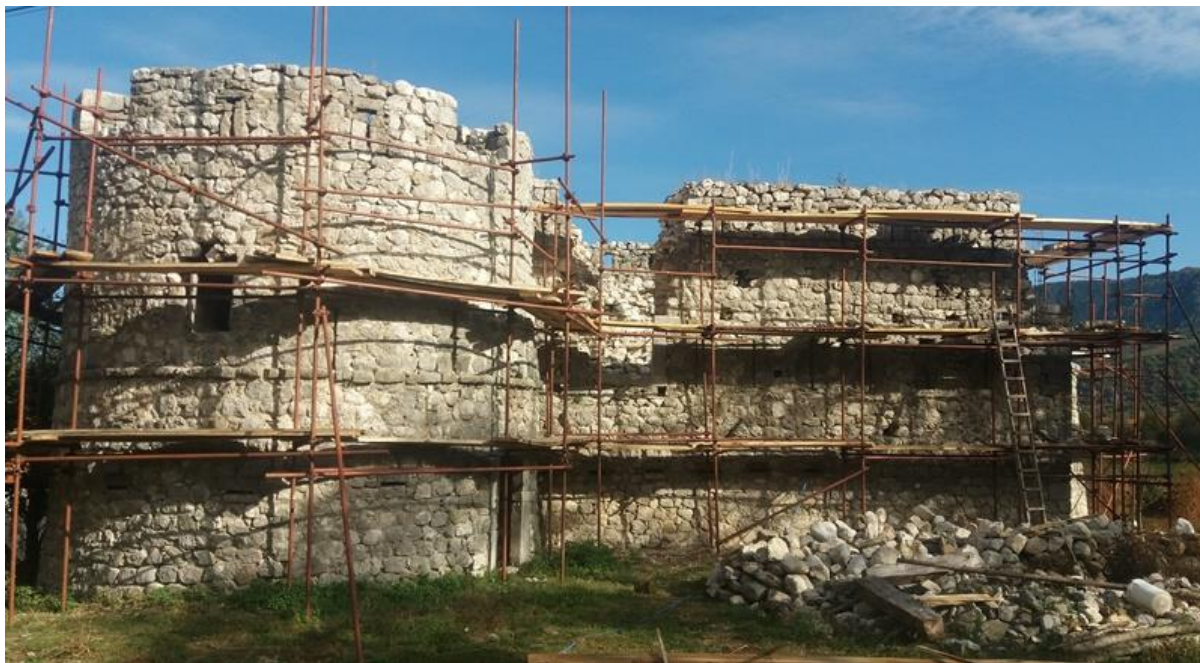
Izgled kule Voltice tokom skorašnje rekonstrukcije
