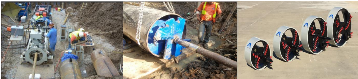
Slika 7.1. Gradilište u Montereu, alat i pripremni radovi ( www.trenchlessinternational.com )
