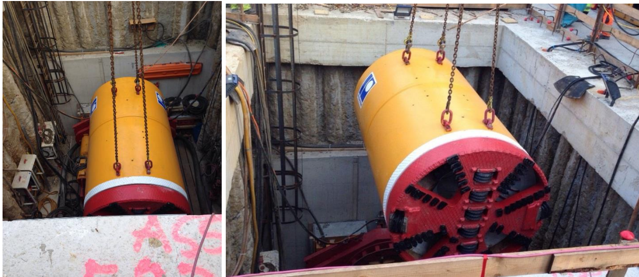
Slika 7.7. Spuštanje opreme u radnu jamu ( Dvojni primarni kanalizacijski kolektori u centralnom dijelu grada Mostara – tender 3 tuneli i obrnuti sifoni – Ludwig Pfeifer)
