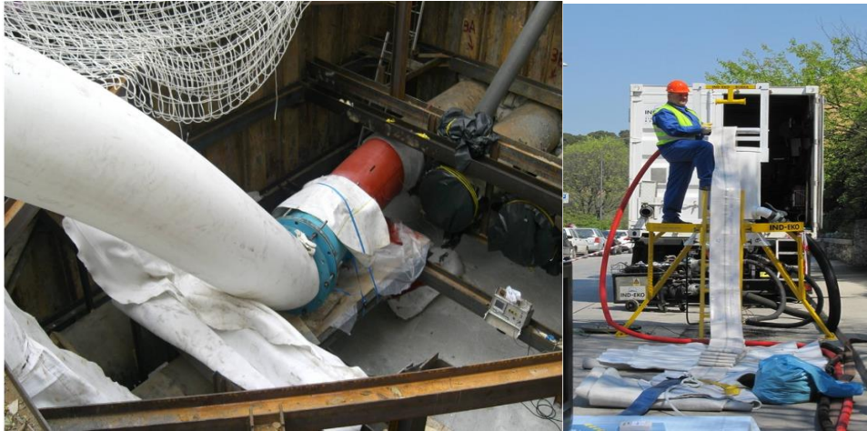
Slika 6.14. Postupak uvlačenja nove cijevi ( www.ind-eko.hr ; www.old.pula.hr )
