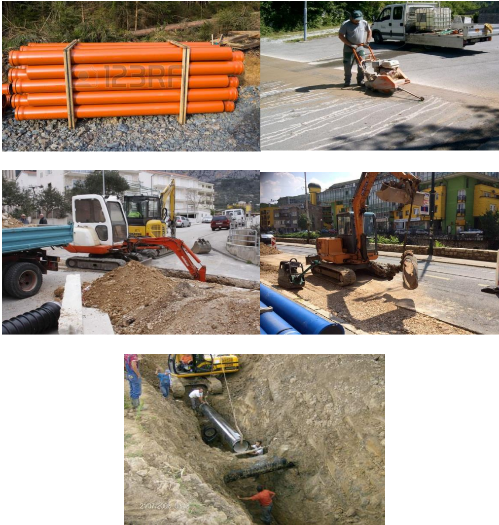
Slika 5.1. Proces zamjene postojećeg cjevovoda ( www.google.com )
