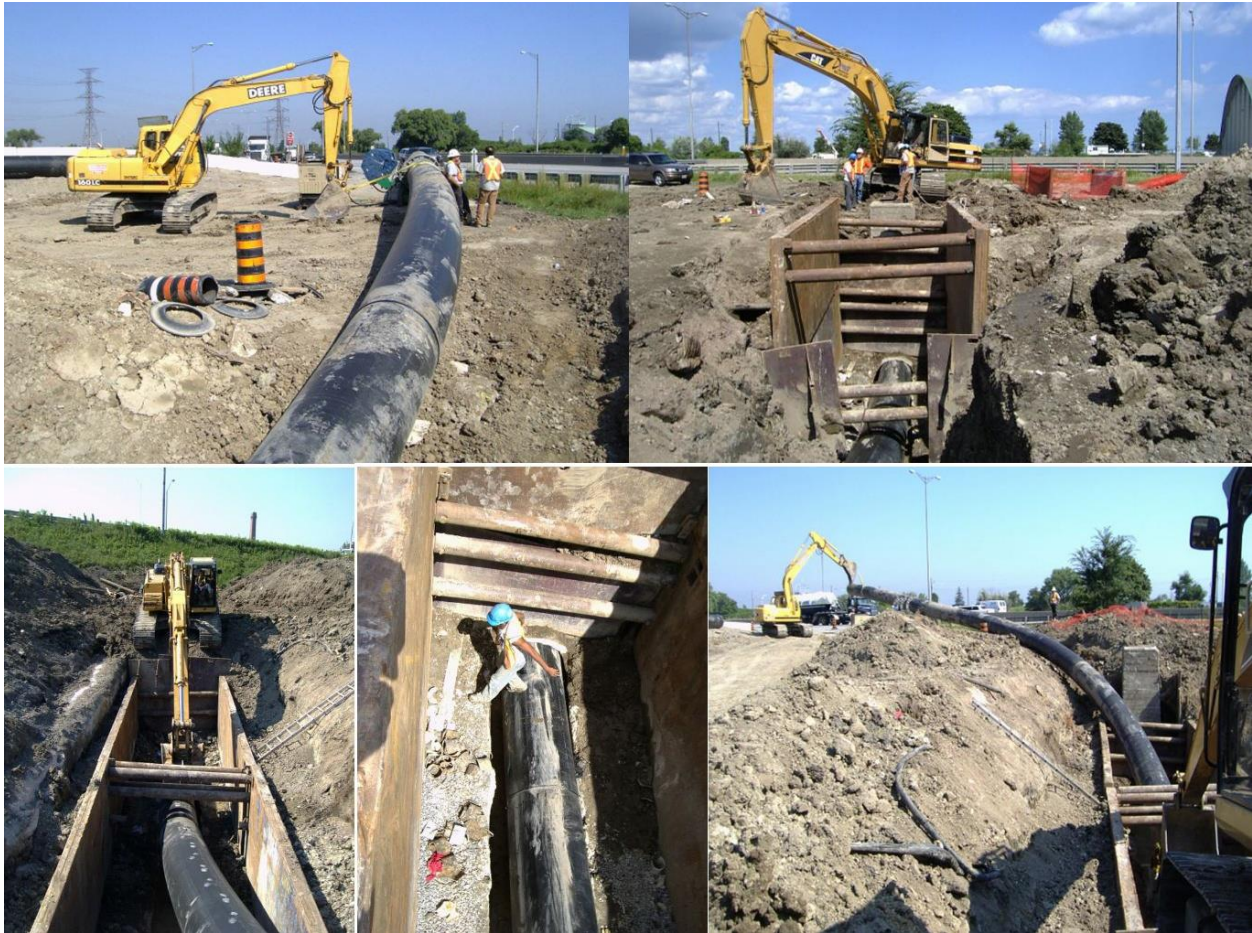
Slika 6.8. Primjena metode sliplining na gradilištu ( www.pipeflo.ca/trenchless-slip-lining.php )
