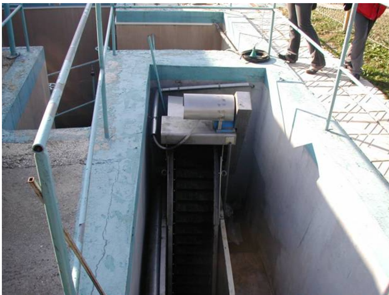
Mehaničko pročiščavanje – rešetka (pivovara Buzet)
