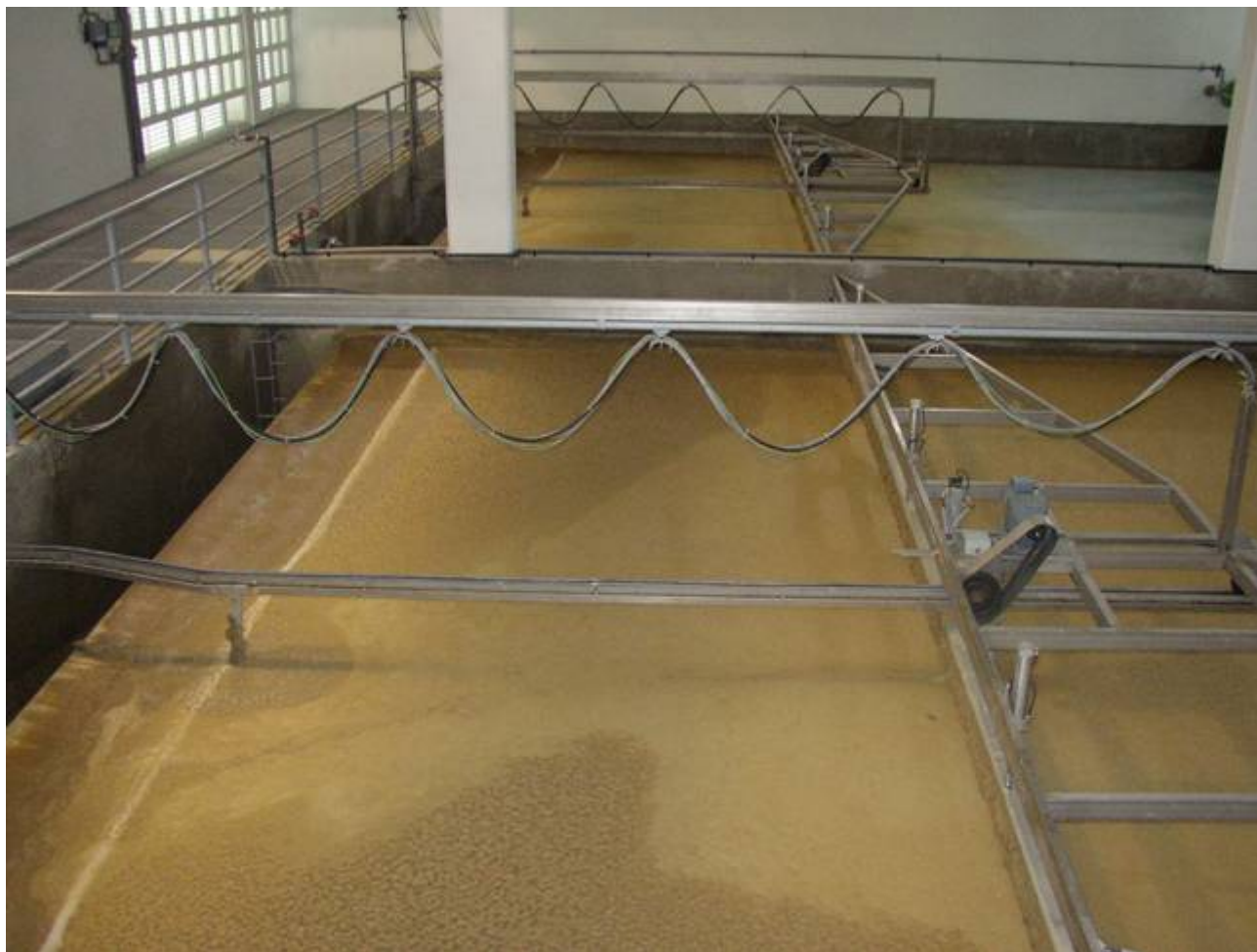
Aerirani flotator (kondicioniranje vode za piće iz Botonege)
