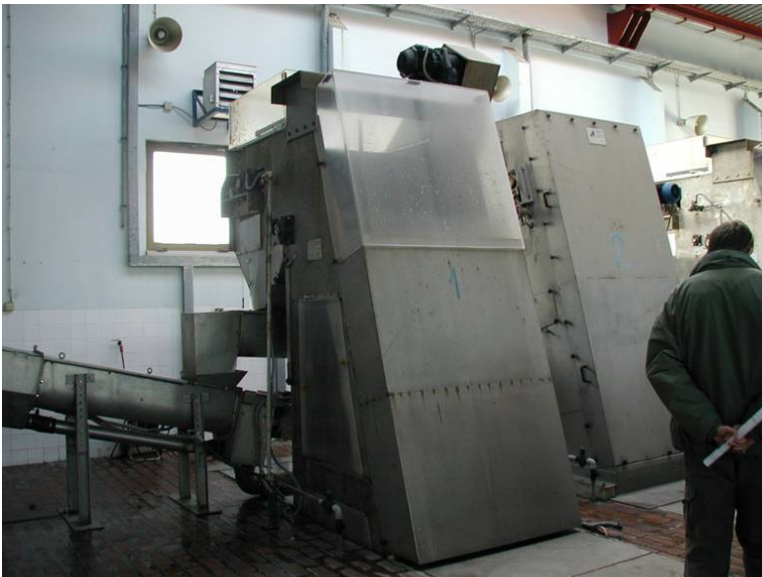
Mehaničko pročiščavanje – rešetka (Delta)
