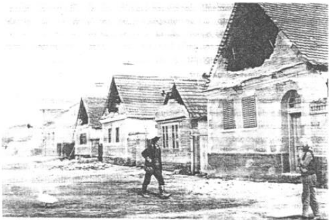
Slika 2.16 Nepridržani zabatni zidovi ruše se i kod slabijeg zemljotresa. Sl. Brod, 1964
