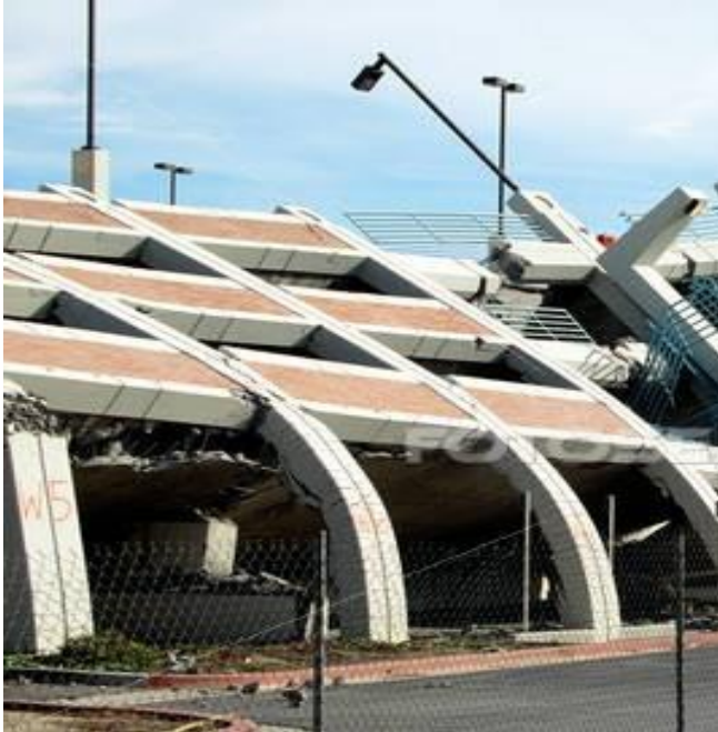
Loše odabran konstruktivni sistem, zemljotres Northridge, Los Angeles, 1994, skeletna konstrukcija, opeka ispuna
