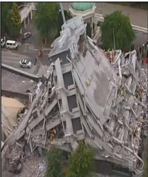
Loše odabran konstrukcijski sistem, Christchurch, New Zealand, februar 2011.
