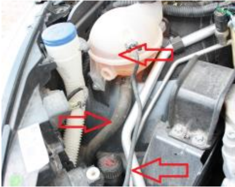
Kontrola rashlade tečnosti i crijevnih spojeva
