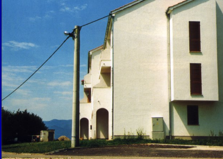
kablovski priključak sa stuba
