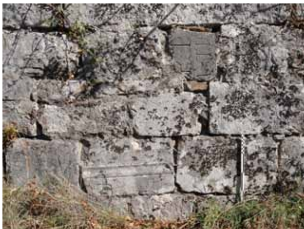
Fig. 19 - Opera muraria con materiale di spoglio, perimetrale interno dell'edificio cruciforme Slika 19 - Zidarski radovi i ponovo upotrijebljeni materijal, područje unutar objekta u obliku krsta
