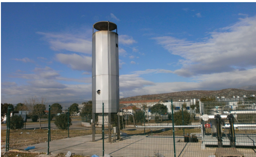
Slika 54. Postrojenje u kojem se sakuplja i spaljuje biogas nastao u kadi deponije (Bojanić Rašović)
