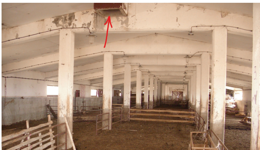
Slika 64. Unutrašnjost ovčarnika - ventilacioni odvodni otvor (označen crvenom strelicom) (Bojanić Rašović)
