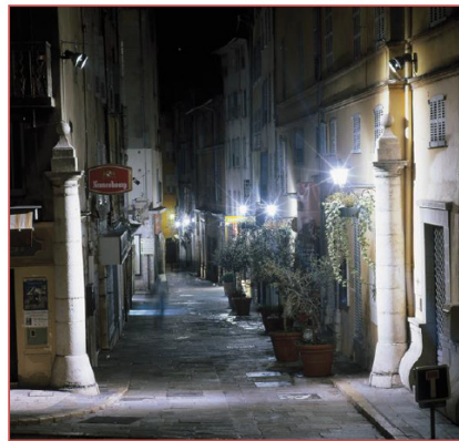
Ulica osvijetljena MH sijalicom (CDO-TT 70W)
