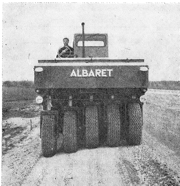
Sl. II.VII — Zbijanje bankine auto-puta „Izopaktorom” (Isopactor) od 27 t (Auto-put Al). Uočavaju se specijalni hidraulični uređaji kojima je moguće vertikalno pomicanje točkova. (Foto Baranger)
