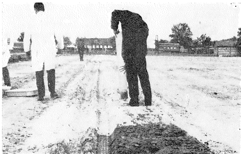
Sl. IV.II — Obrada prašine krečom: aerodrom Bos (Bos) (76)
