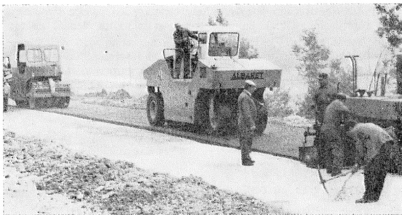
Sl. IV.IV — „Ortopaktor P.3” od 22 tone iza koga dolazi tandem-valjak DHT težine 8/12 tona. Zbijanje asfaltne mešavine postupkom „valjak s gumenim točkovima napred”, na nacionalnom putu R. N. 1
