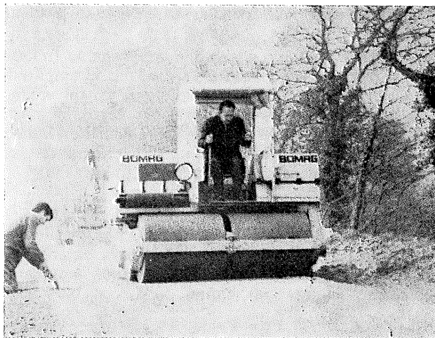
Sl. II.XII — Vibracioni valjak dupleks od 7 t, naročito prilagođen za cementom ili zgurum obradene šljunkove
