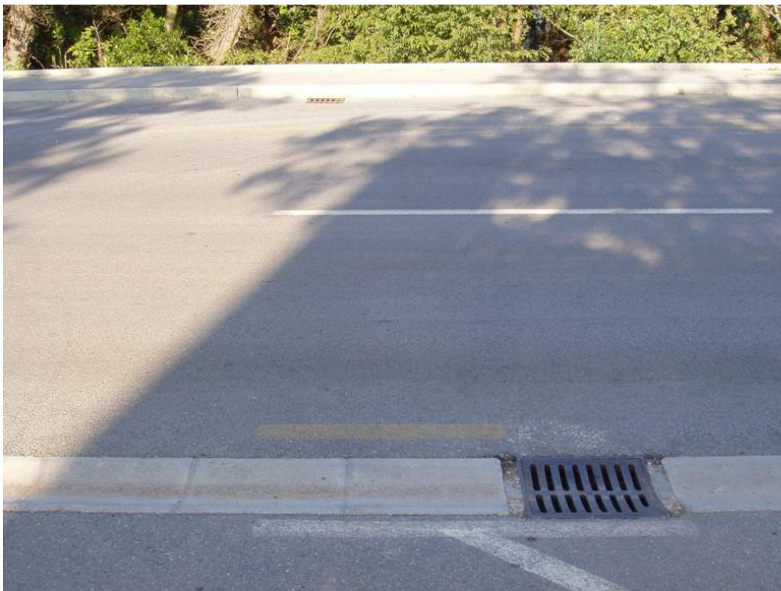
Odvodnja vode s kolnika i parkirališne površine
