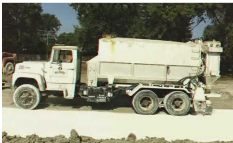
Слика 3.8: Аплицирање сувог креча
