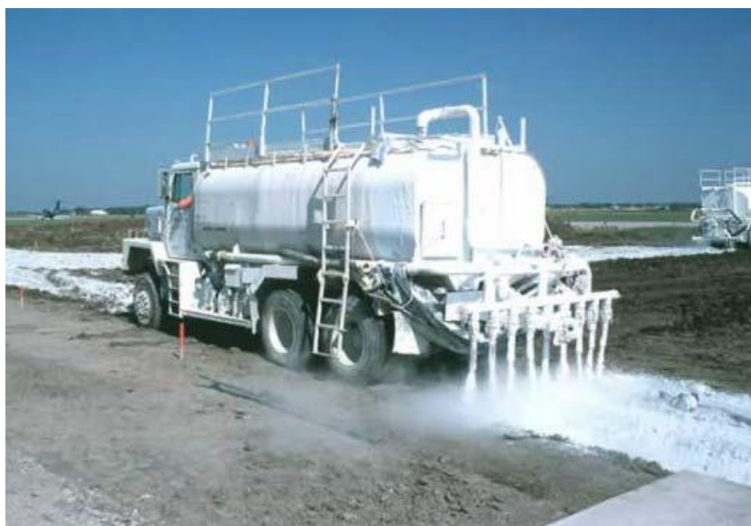
Слика 3.7: Аплицирање течног креча
