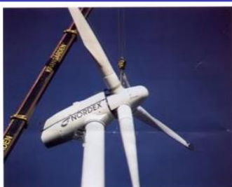
Nordex 2,5 MW , promjer rotora turbine je 80 metara.
