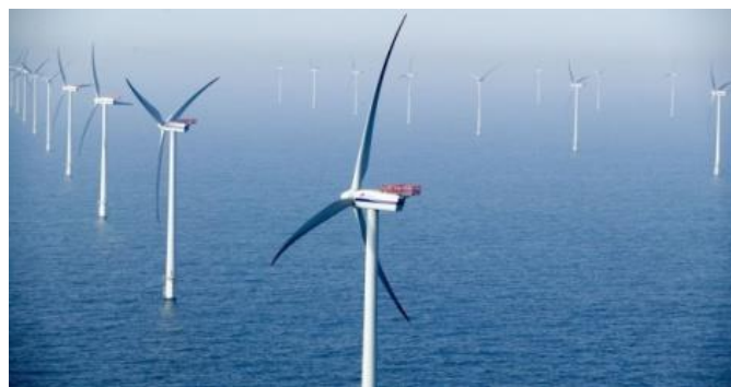
Slika 2.2.3.6. Vjetroelektrana na moru (offshore).
