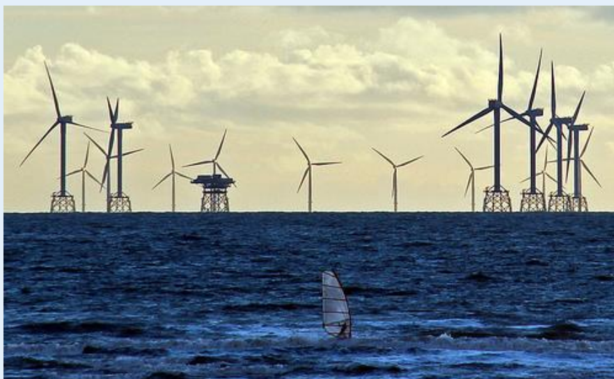
Slika 2: Priobalna vjetroelektrana Walney
