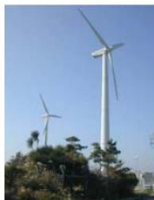
NEG Micon 2 MW, promjer rotora te turbine je 72 metra.
