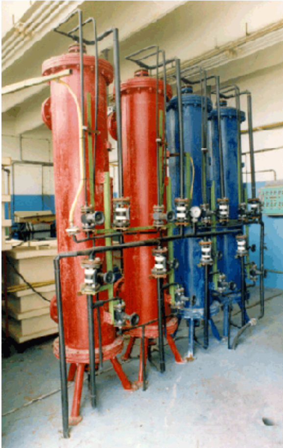
Slika - Automatska protočna postrojenje za pripremu demi vode - jonoizmenjivači
