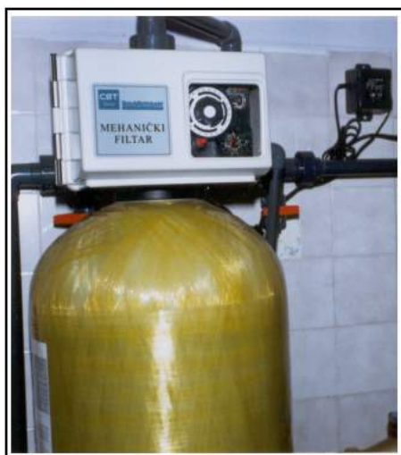
Slika - Izgled montiranog automatskog sistema, sa automatskim ventilskim glavama
