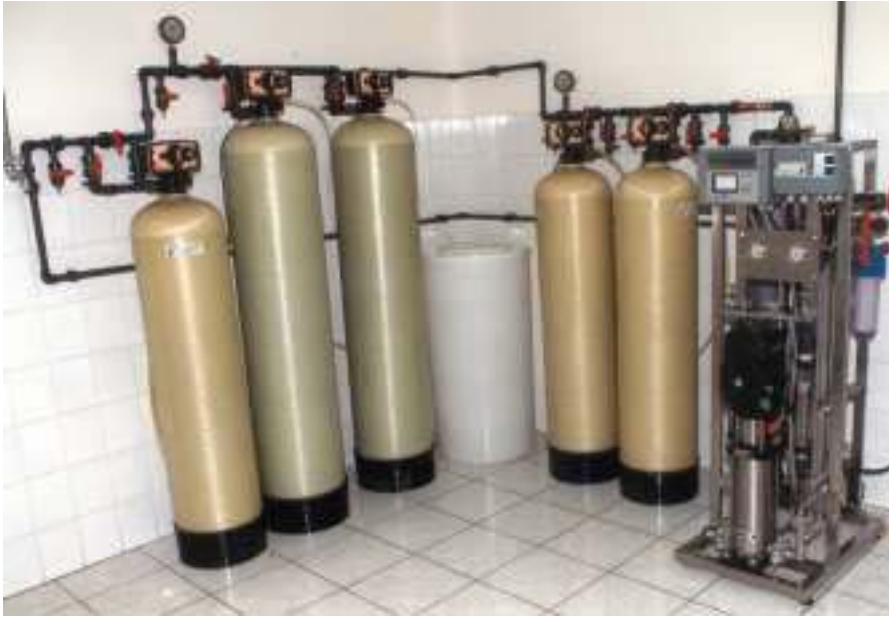
Slika RO Stanica, kapaciteta 400 l/h i RO Blok, kapaciteta 1200 l/h (4 RO Modula)
