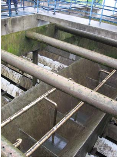
Slika Pulzator - (koncentrator mulja)
