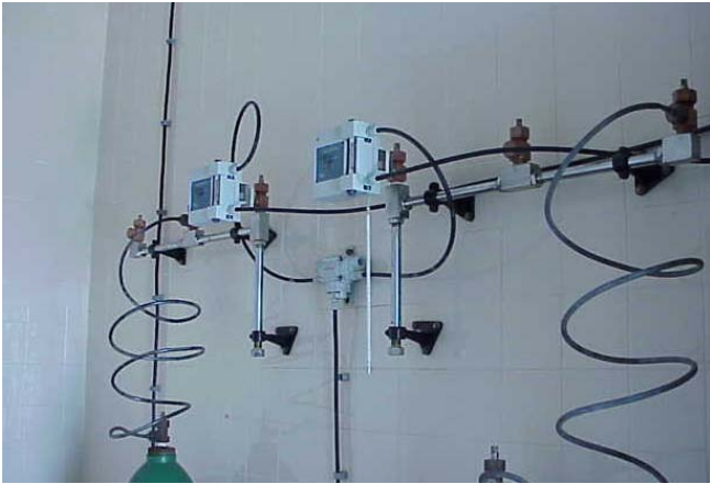
Slika Hlorinatori za doziranje gasnog hlora
