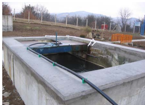
Slika Komora za brzo mešanje
