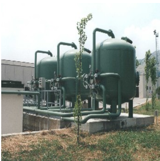
Slika - Rezervoari za zrnasti aktivni ugalj
