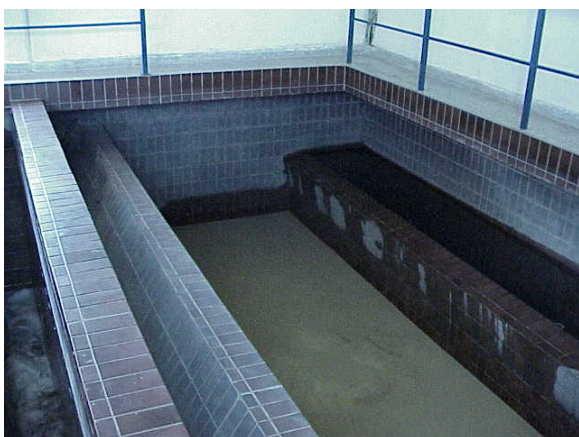
Slika Filterska ispuna
