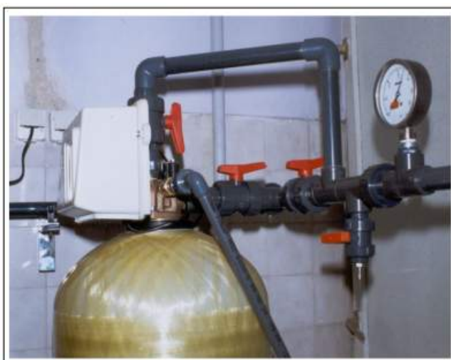
Slika - Izgled montiranog automatskog sistema, sa automatskim ventilskim glavama
