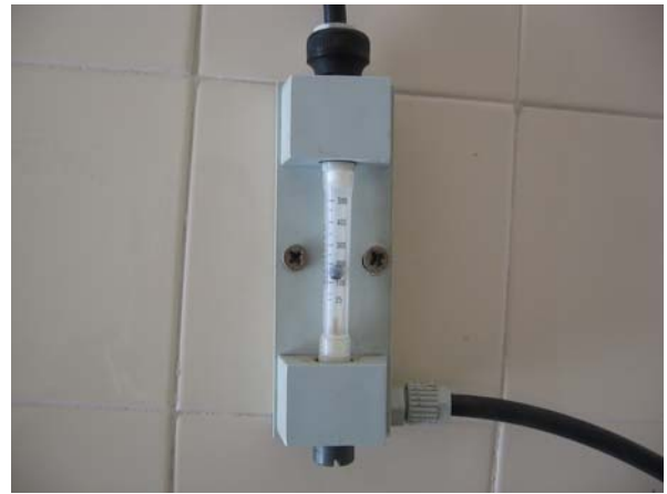
Slika Rotometar za ručno podešavanje doze hlora
