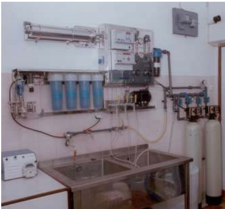
Slika RO Stanica, kapaciteta 80 l/h i RO Blok, kapaciteta 400 l/h (2 RO Modula)
