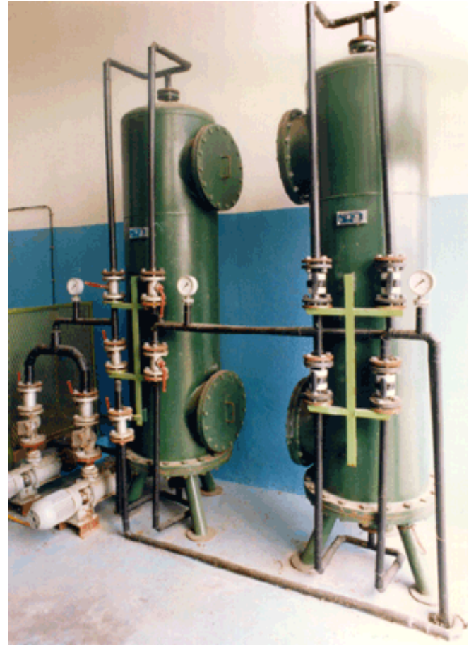
Slika - Automatska protočna postrojenje za pripremu demi vode - jonoizmenjivači
