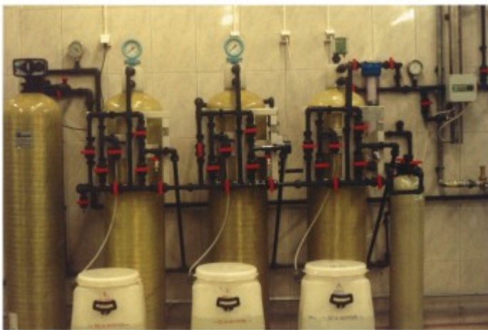
Slika - Izgled jednog montiranog sistema proširene verzije demineralizatora
