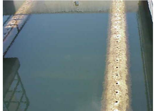
Slika Sistem cevi za sakupljanje bistre vode
