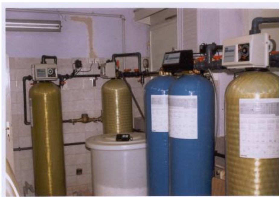
Slika - Automatska duplex verzija uređaja za omekšavanje vode.
