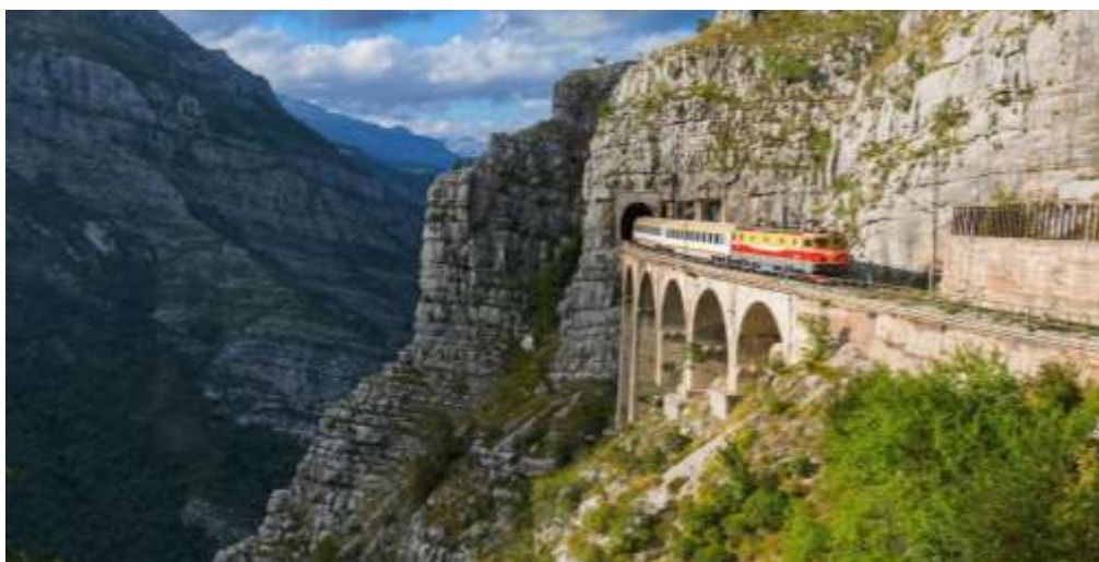
Slika br. 4.6: Željeznička pruga u Crnoj Gori
