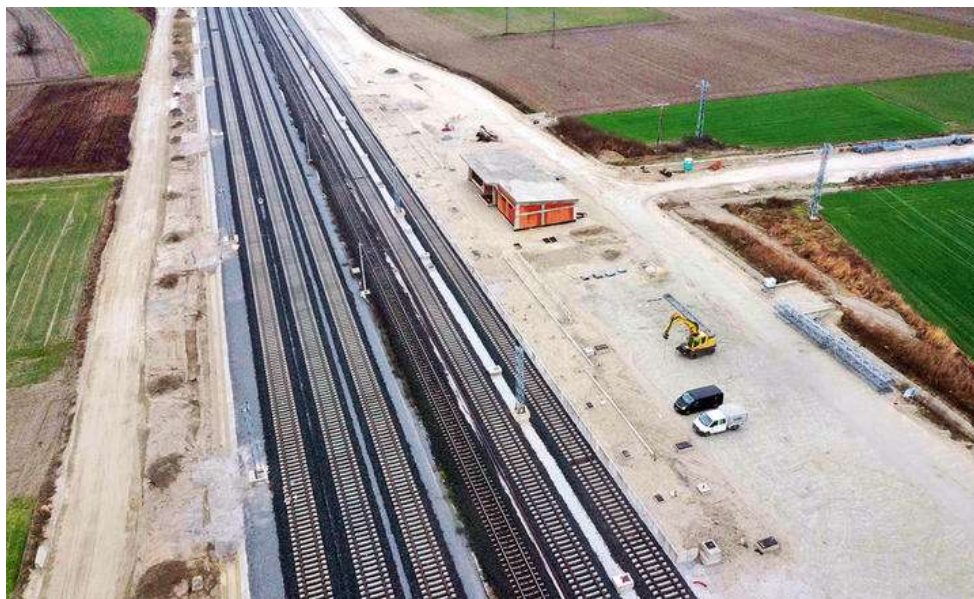
Slika br. 2.1: Obnova željezničke pruge u Hrvatskoj u 2023.
