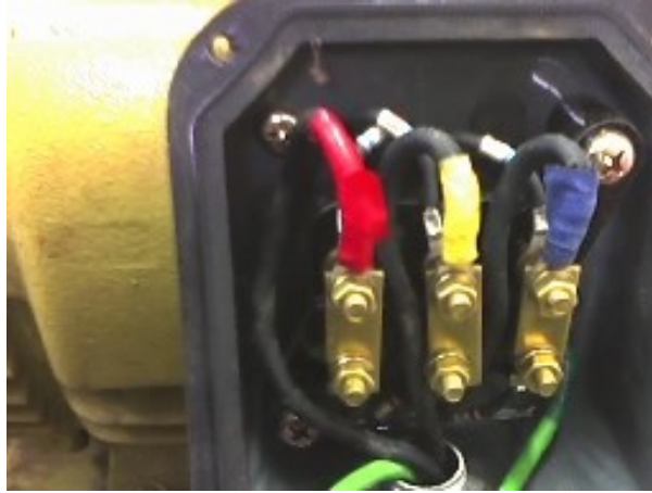
Slika p1.4. Sprega trofaznog namotaja statora u trougao
