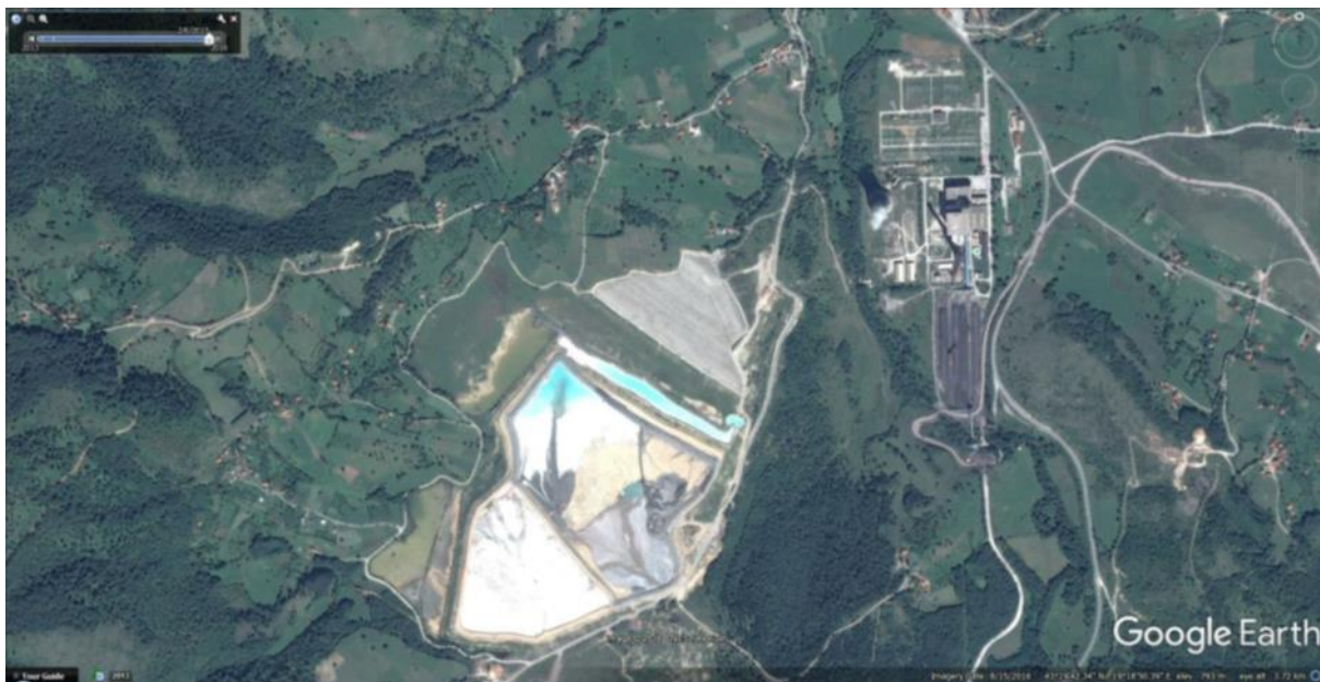
Slika 11. Lokacija deponije "Maljevac"
