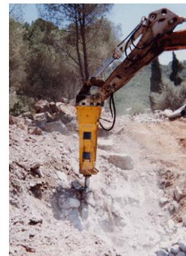
**udarni rijač, udarni riper** → rijač, riper
