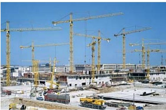
konstrukcija. Sastoje se od okretnog i po potrebi na tračnicama okretnog tornja na kojem se nalazi krak (grana, strijela) s opremom za dizanje tereta pomoću užadi. Krak može biti *vodoravna grana* (po njemu putuje oprema za dizanje) ili *kosa strijela* okretna u uspravnom smislu (oprema za dizanje ima hvatište na kraju kraka). Prevladavaju uglavnom *toranske dizalice s vodoravnim granom* (*slika lijevo←*).
