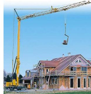
prijenosne, uglavnom velike (potrebno je rastavljanje prilikom premještanja), te polupokretnе ili samohodne samosastavljajuće manje toranske dizalice (*slika desno→*). Toranske dizalice na kamionskom podvozju jesu
