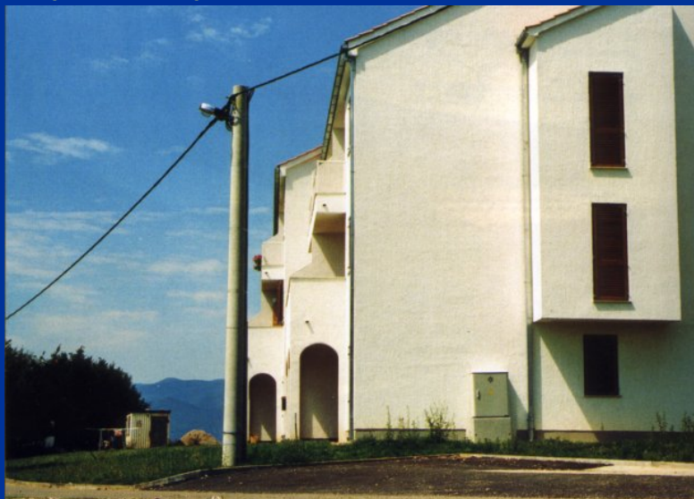
kablovski priključak sa stuba
