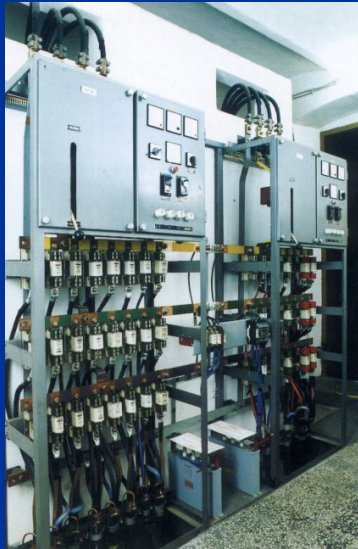
NN razvod u SN TS 2 x 400 kVA
